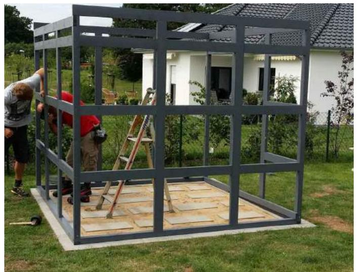
Die äußeren Riegel einer Seite verschrauben Sie an der Außenseite, ebenfalls nach dem Vorbohren, mit C105-0100, durch den Pfosten. Die inneren Schrauben setzen Sie schräg von unten durch den Riegel in die jeweiligen Mittelpfosten.
