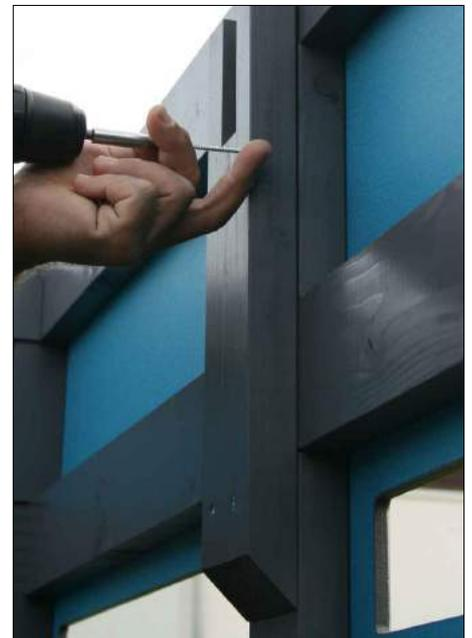
Verschrauben Sie die Pfettenschuhe nach dem Vorbohren mit jeweils 4x C105-0060 von innen an den Mittelpfosten.
