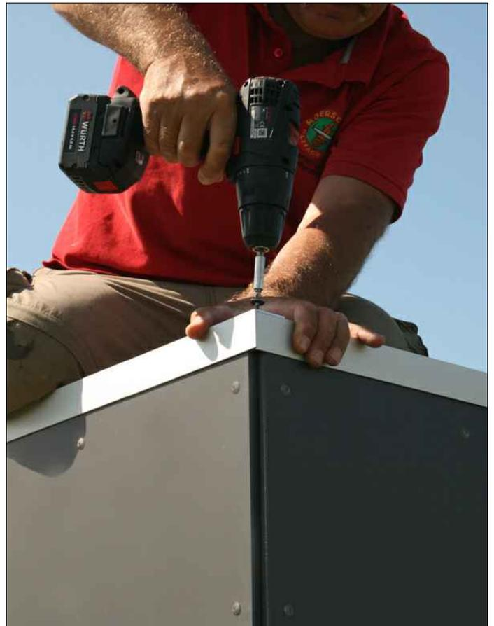
In den Ecken legen Sie die Schienen übereinander und verschrauben Sie diese mit nur einer Schraube zusammen.
