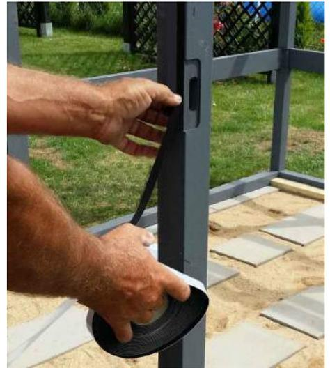
Bekleben Sie das Grundgerüst mit dem EPDM Dichtband A109 (9mm breit) und A111 (30mm breit). Verwenden Sie für die Bereiche in denen 2 Platten aneinander stoßen A111 und für die Ober- und Unterseite des Gerüsts A109. Das Dichtband muss ohne Abstand dicht auf Stoß geklebt werden um eindringendes Wasser zu verhindern. In den Eckbereichen kleben Sie das Dichtband zu gleichen Teilen um die Ecke. Halten Sie oben einen Abstand von 0,5cm bis zur Kante!
