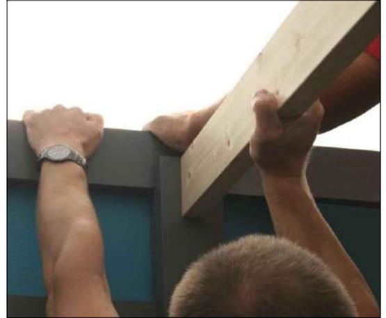
Um die genaue Lage der Pfette(n) und der Pfettenschuhe zu ermitteln, legen Sie ein Dachbrett hochkant vom Auflager vorne bis über die hintere Rähm. Zeichnen Sie dann die Oberkante der Pfette(n) an und ermitteln so genaue Lage der Pfettenschuhe.
