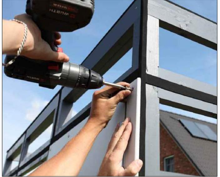
Beginnen Sie beim Verschrauben der Platten mit den schmalen Streifen rechts der Tür. Kontrollieren Sie die rechten Winkel mit der Wasserwaage und lassen Sie 1cm Luft zwischen den Platten!
