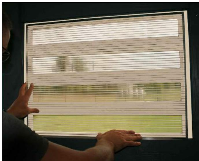
Stellen Sie nun die Doppelstegplatten C200-250 in die entsprechenden Rahmen an das Dichtband und messen die Länge der Blendeleisten ab, um diese entsprechend zu kürzen.
