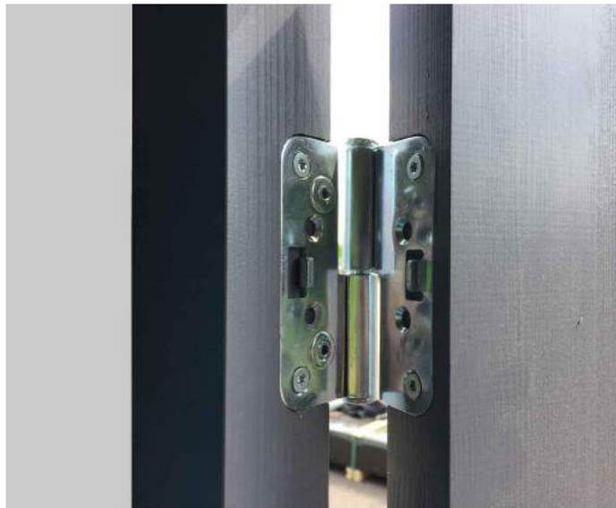
Hängen Sie nun die mit den Fassadenplatten versehene Tür mit den Scharnieren in das Grundgerüst ein.
