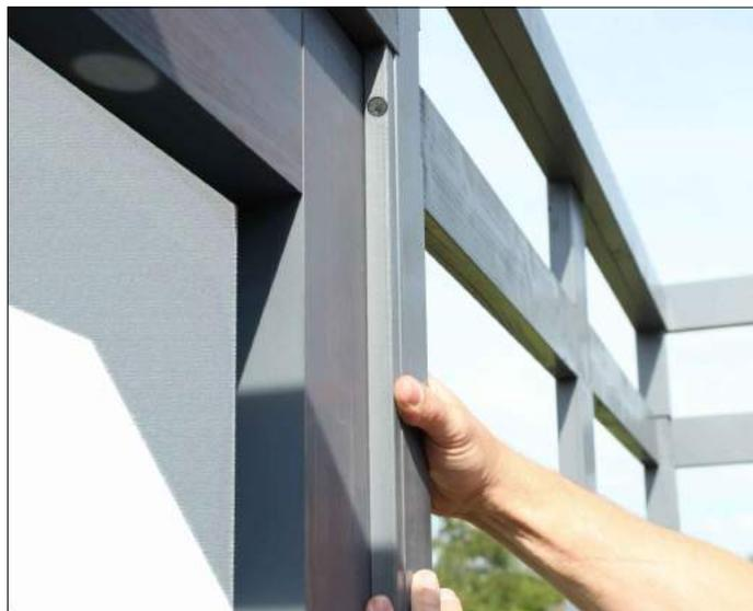
Schließen Sie nun die Tür, richten die Frontwand parallel zur Tür aus und dübeln Sie diese dann mit der Schwelle am Fundament an. **(Dübel sind nicht im Lieferumfang enthalten!)**
