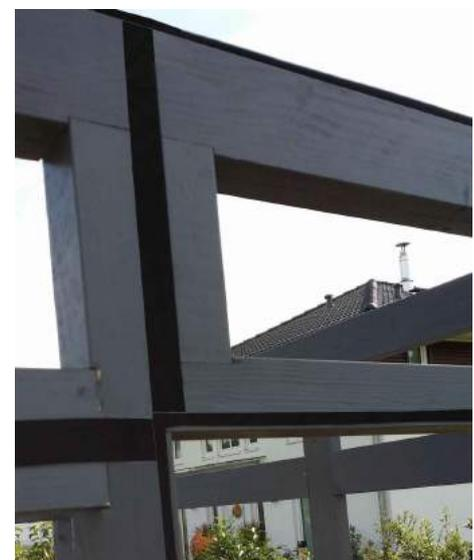
Beginnen Sie mit dem unteren Dichtband (A109) 2cm von der Unterkante des Gebäudes. Kleben Sie das Dichtband generell genau auf Stoß um das Eindringen von Feuchtigkeit zu verhindern!
