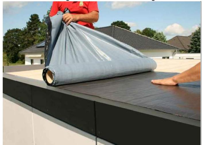
Nach dem vollständigen Verkleben der ersten Bahn nehmen Sie nun die zweite und lassen sie ca. 20cm überlappen. Durch Anwalzen besonders im Überlappungsbereich gewährleisten Sie eine gute Verklebung.
