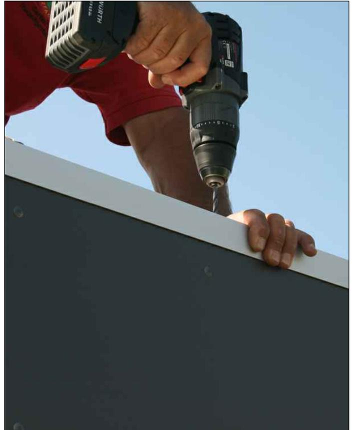
Verschrauben Sie die Aluminiumschienen ( A100-220) nach dem Vorbohren mit 6x C104-0030 an der Dachkante mit der Rähm. Lassen Sie die Längsstöße der Aluminiumschienen 2cm überlappen
