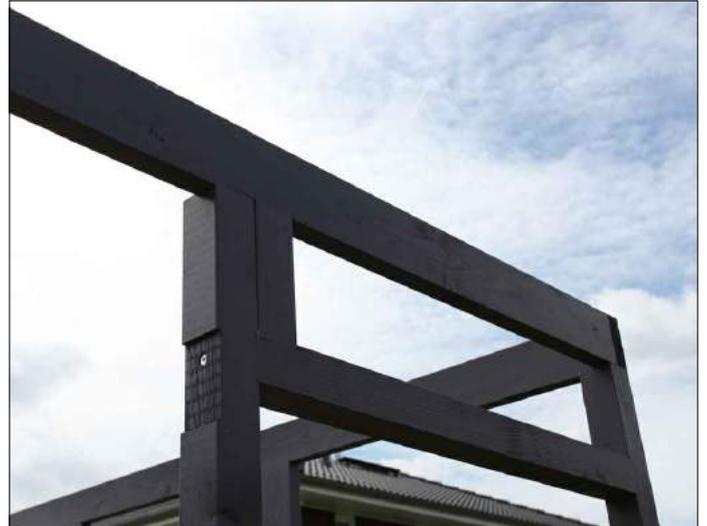
Legen Sie die das waagerechte Kantholz für den Türsturz in die dafür vorgesehene Aussparungen und achten Sie darauf die Bauteile an den Außenkanten bündig zu setzen. Bohren Sie vor und verschrauben mit 2x C105-0100 jeweils von aussen durch die Pfosten. Halten Sie beim Schrauben ca.4cm Abstand von der Außenkante.
