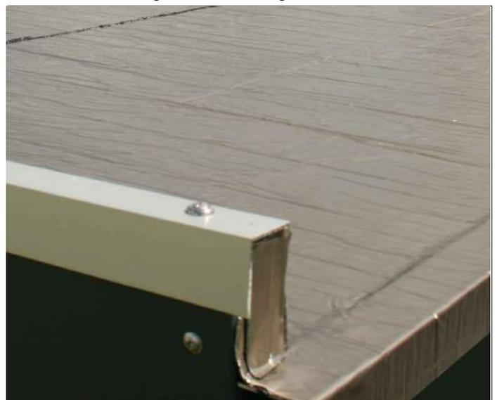
Nach dem Verkleben und Anwalzen der Dachbahnen schneiden Sie nun die Randbereiche der Bahnen mit einem Cuttermesser passend zu. Der Randbereich wird später von der Aluminiumschiene verdeckt.
