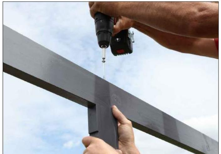
Fügen Sie nun die Mittel- und Eckpfosten in die jeweiligen Vertiefungen der Rähm, bohren Sie vor und verschrauben Sie die Rähm mit den Schrauben 2x C105-0150 von oben mit den jeweiligen Pfosten.
