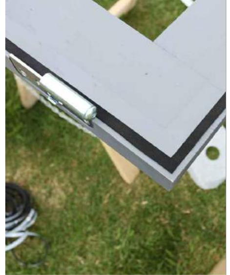
Bringen Sie nun das 9mm breite Dichtband (A109) auf den äusseren Rand der Außenseite der Tür auf und halten Sie dabei einen Abstand von 3mm zur Außenkante. In der Mitte wo die Platten stoßen verwenden Sie bitte A111.
