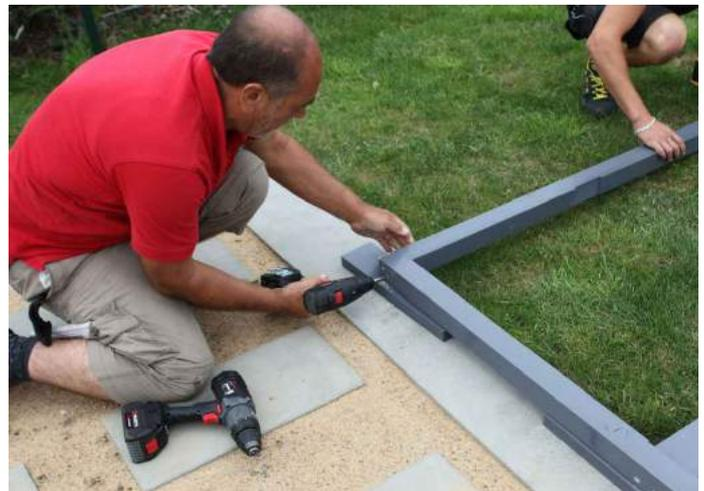
Schrauben Sie dann die beiden Eckpfosten im Türbereich an der vorgesehenen Aussparung ebenfalls mit 2x C105-0100 von unten durch die Schwellen an. Bitte beachten Sie dabei die Richtung der Pfosten bezüglich der Türbeschläge!
