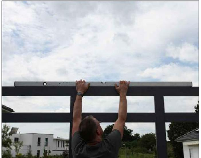
Um eine optimale Anbringung der Fassadenplatten zu gewährleisten stellen Sie mit Hilfe einer Wasserwaage sicher dass sich die Konstruktion im Lot und in der Waage befindet. Überprüfen Sie auch den oberen Teil der Konstruktion.
