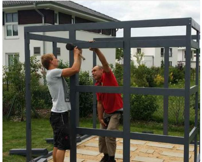
Verbauen Sie die restlichen Riegel nach dem gleichen Verfahren. Beginnen Sie mit den drei mittleren Riegeln einer Seite und verschrauben Sie nach dem Vorbohren mit C105-0150 von aussen durch die Pfosten. Halten Sie 1,5cm Abstand von der Außenseite der Konstruktion.
