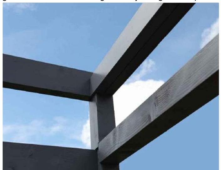
Positionieren sie nun das Kantholz als Auflager für die Dachbretter auf den Eckpfosten an der Frontseite, bohren vor und verschrauben es mit 5x C105-0050 von innen an der Rähm. Halten Sie aussen einen Abstand von ca. 5cm ein.
