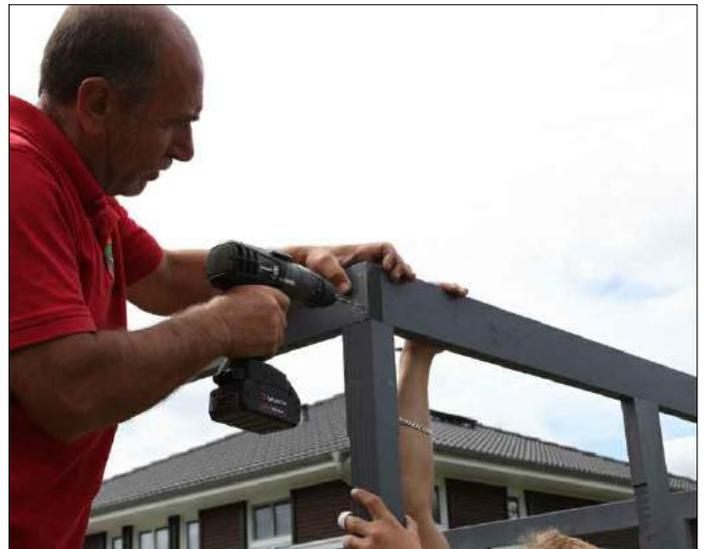
Verschrauben Sie nun die in den Ecken auf gleicher Höhe liegenden Teile der Rähm nach dem Vorbohren mit 2x C105-0080. Setzen Sie die Schrauben mit einem Abstand von 1,5cm von der Außenkante.
