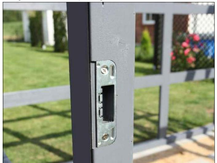
Positionieren Sie dann den Beschlag (wählen Sie das längliche Schließblech aus dem Paket, wie hier dargestellt) für das Schloß in der Aussparung am linken Türpfosten und verschrauben sie diesen nach dem Vorbohren mit 2 der dem Schloß beiliegenden Schrauben.
