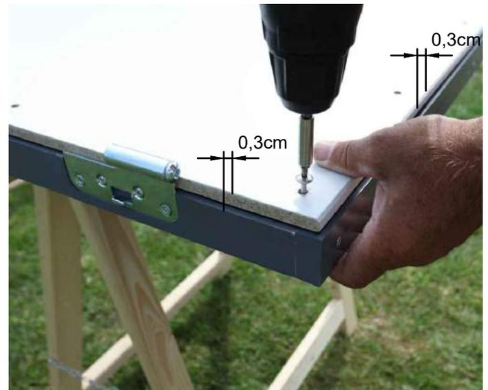
Nun schrauben Sie die oberste Fassadenplatte mit der gleichfarbigen Schraube auf den Türrahmen auf, achten Sie dabei darauf im rechten Winkel zu bleiben und schrauben Sie ganz gerade ein.
