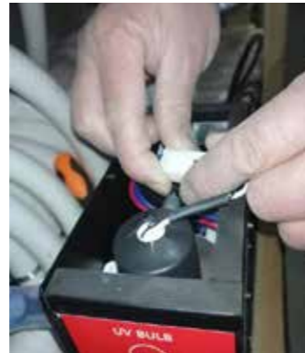
7. Schritt: Weiße Verbindungsstücke wieder verkuppeln
