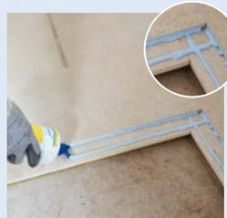
Das gleichzeitige Auftragen des Estrichklebers auf den Stufenfalz sowie im Kantenbereich ist durch die Doppelstrangdüse gewährleistet.
