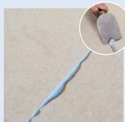
Ein „Ausquellen“ des Klebers aus dem Falzbereich zeigt die optimale Klebverbindung. Sobald der Kleber oberflächlich abgebunden ist (je nach Temperaturbedingungen ca. 1 Stunde), kann dieser mit einem Spachtel abgestoßen werden und somit ist die Oberfläche glatt und planeben.
