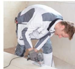
Für den Wandanschluss ist der Stufenfalz abzutrennen
