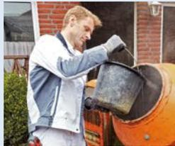
Das Material sollte ca. 3-4 Minuten durchgemischt werden und ist dann für die Aufbringung auf den Rohboden gebrauchsfertig.
