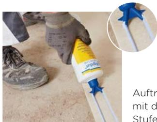
Auftragen des Rigidur Estrichklebers mit der Doppelstrangdüse auf den Stufenfalz und der Plattenkante.
