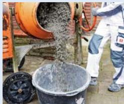
Das angemischte Schüttungsmaterial wird auf dem Rohboden verteilt **1**. Bei hohen Schütthöhen können ebenfalls parallele Dämme zur Auflage von Abziehleuten hergestellt werden **2**. Die Verteilung und Glättung der Schüttung erfolgt über die Abziehleuten **3**. Mit dem planebenen Glätten der Oberfläche ist die gebundene Schüttung fertig und kann nun trocknen. Die Trocknungszeiten können variieren, da diese in Abhängigkeit der Schütthöhen stehen **4**.
