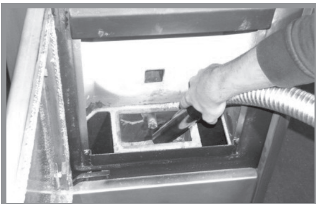
Abb. 12f: Reinigung Brennraumbehälter
