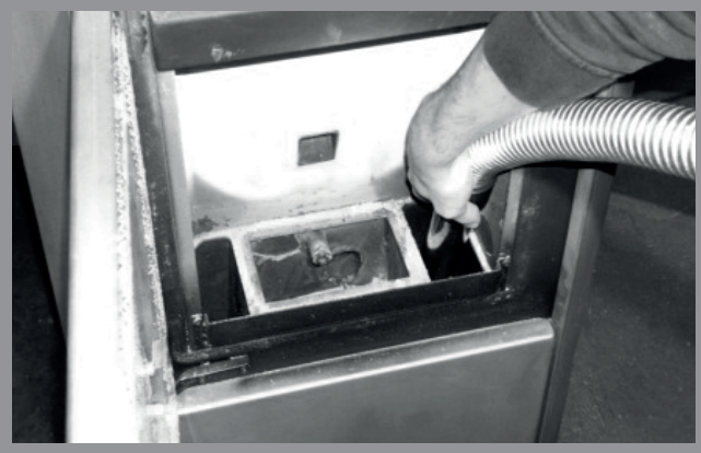
Abb. 12g: Reinigung untere Brennkammer
