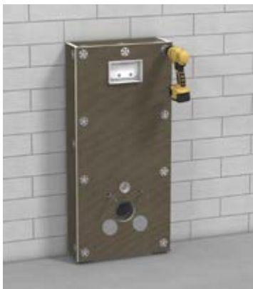
9.6 Montagetafel anschrauben
