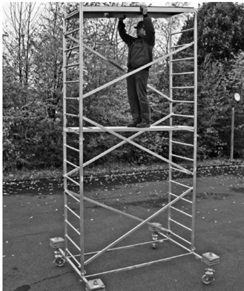
Heng deretter plattformen med de tiltenkte åpningene i de øverste tverrstykken på vertikalrammen. Trekker deretter til de allerede monterte sikringssettene.
