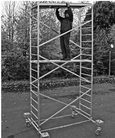
Hängen Sie dann die Belagbühne mit den dafür vorgesehenen Öffnungen in die obersten Sprossen der Vertikalrahmen ein. Ziehen Sie nun die schon vormontierten Sicherungssets fest an.
