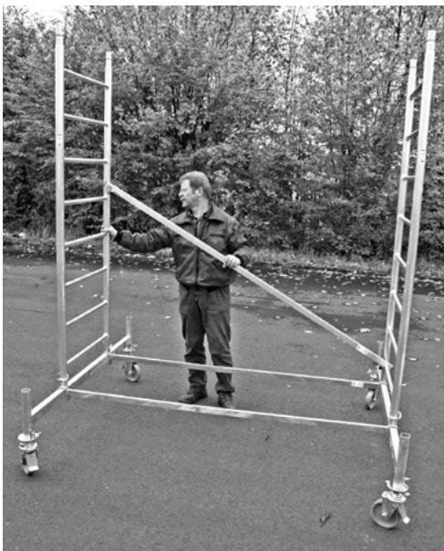
Nehmen Sie die zweite Diagonale und montieren Sie diese, wie im Bild gezeigt, entgegengesetzt diagonal von der ersten in die fünfte Sprosse und befestigen Sie auch diese mit den Sicherungssets.
