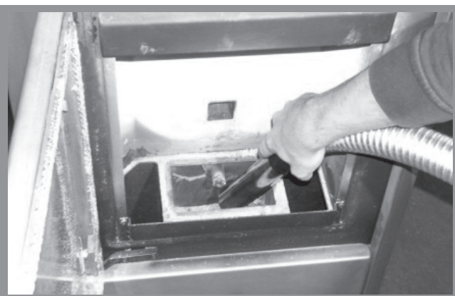
Abb. 12f: Reinigung Brennraumbehälter
