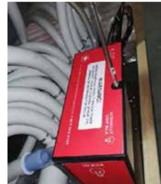
8. Schritt: Rote Abdeckung wieder festschrauben
