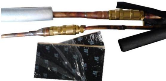
8. Wickeln Sie die schwarzen Bitumenmatten eng und fest um die Quick-Verschraubungen. Siehe Abb. 4.12
