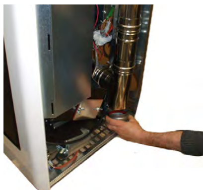
Fig. 82 - Reinigung des Rauchgaskanals
