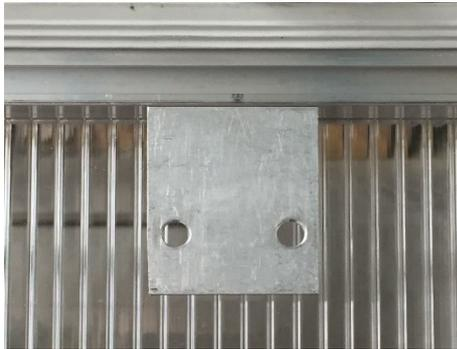
Mit den Linsenkopfschrauben 4,2 x 13 (Pos. 8) verschrauben Sie den Befestigungswinkel (Pos. 9) am Deckel des Frühbeets.
