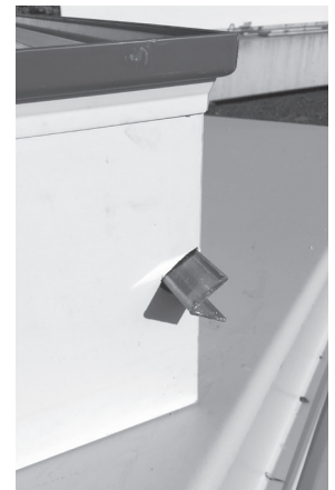
Verstärkungseisen entnehmen
