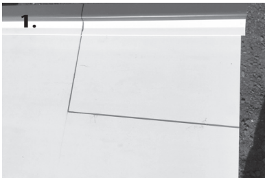
1. Wandanschlussprofile entfernen. Auszuklinkenden Bereich anzeichnen
