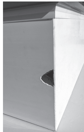
Profilkammer mit weiteren Bohrungen sowie öffnen, so dass das Verstärkungseisen entnommen werden kann
