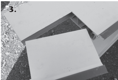
2. Ausklinkung mit Stichsäge vornehmen
