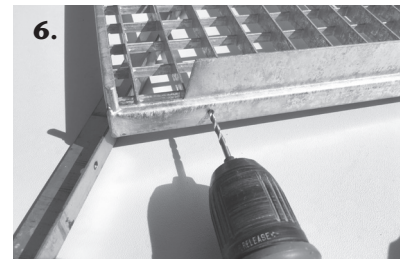
6. Mit 4 mm Bohrer vorbohren
