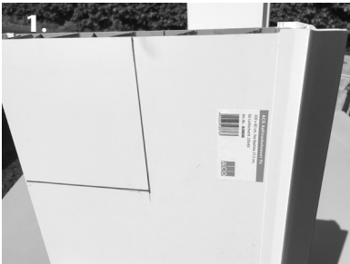
1. Wandanschlussprofile entfernen und Ausklü- nkung anzeichnen
