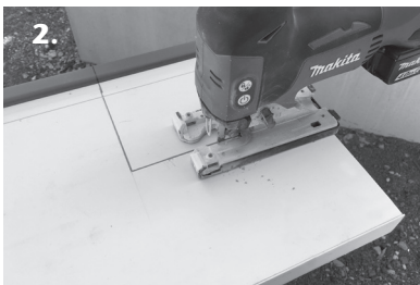
2. Ausklinkung mit Stichsäge vornehmen
