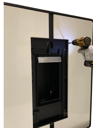
Fig. 40 - Befestigen der Verkleidung
