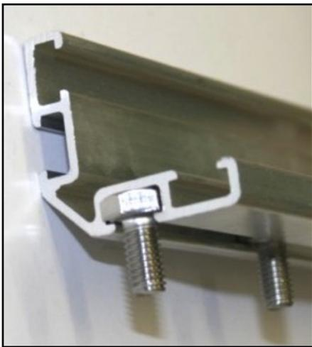
In den unteren Kanal, auf der Innenseite der Längsprofile (Pos. 1/1.1) ziehen Sie pro Gewächshausprosse eine Sechskantschraube M6 x 16 vom Ende her ein.
