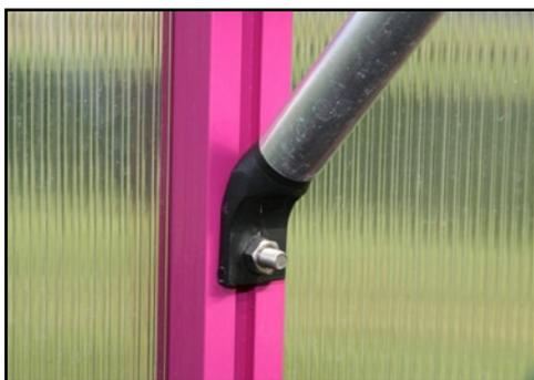
Tisch/Borte an den Gewächshausprossen verschrauben. Hierzu die Streben (Pos. 3) und die Auflagewinkel (V185) an den Sprossen mit Hilfe der Hammerkopfschrauben M6 x 16 (S15) anschrauben.
