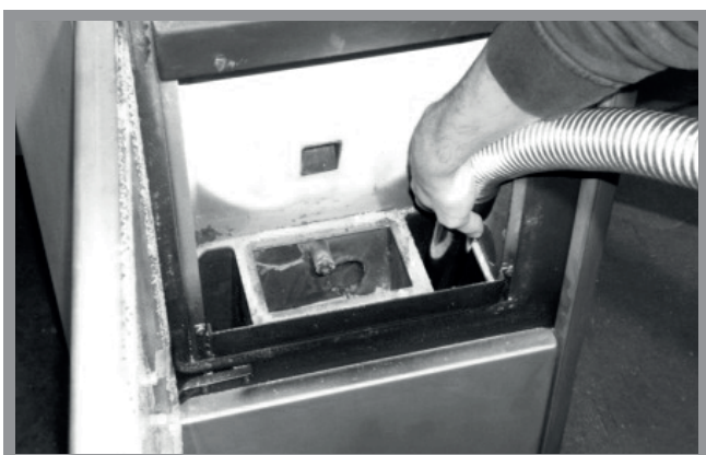
Abb. 12g: Reinigung untere Brennkammer
