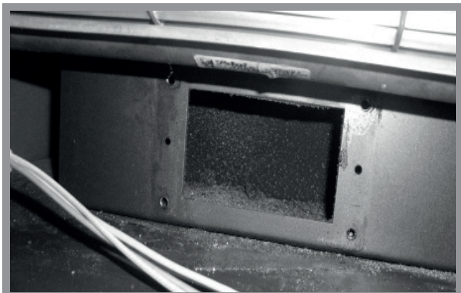
Abb. 13c: Aussaugen der Frontplatte
