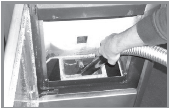
Abb. 12f: Reinigung Brennraumbehälter
