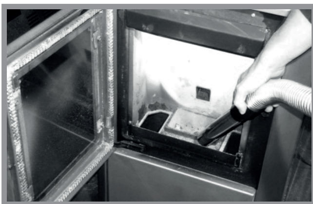
Abb. 12a: Reinigung des Brenntopfes
