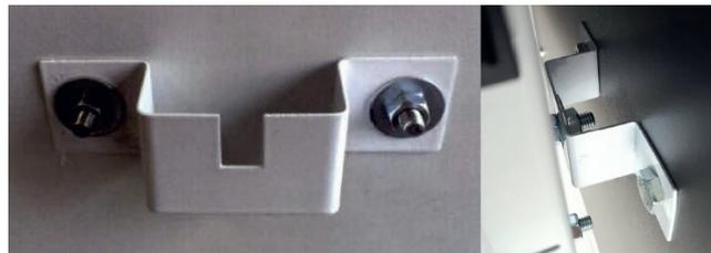
Die Haltebügel werden mit jeweils zwei Schrauben fixiert. (entsprechend des Untergrundes wird i.d.R. gedübelt)
