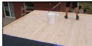
3. Die zurückgeschlagene Folie auf den mit Kleber eingestrichenen Teil ziehen und mit einem Besen von der Mitte des Daches aus die Folie glatt streichen, sodass die Falten beseitigt werden. Diese Arbeitsschritte mit der verbliebenen Folie wiederholen.
