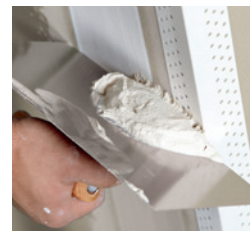
Aufgeklebter AquaBead Kantenschutz
