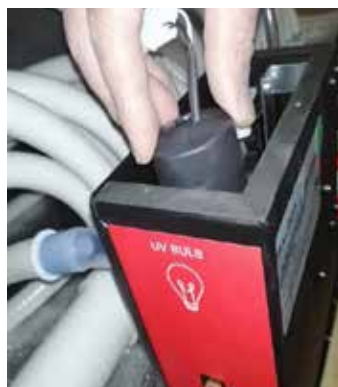
6. Schritt: Neues UV Licht in die Metallröhre stecken und schwarze Abdeckung wieder darauf stecken
