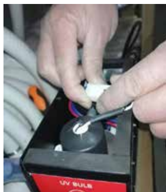
7. Schritt: Weisse Verbindungsstücke wiederverkuppeln
