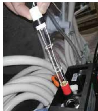
5. Schritt: UV Licht zum Wechseln rausnehmen
