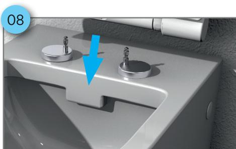
Stecken Sie nun die Abdeckkappe (5) auf die Nylonplatte (3) und schieben anschließend den WC-Sitz wieder auf die Zapfen, sodass er einrastet.
